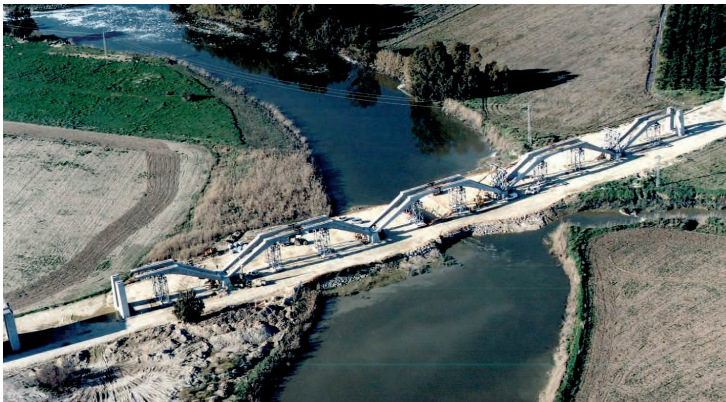
Vista aérea Tramo 4. Montados los arcos prefabricados y las vigas. Ejecutándose los macizos de conexión arcos-vigas. Abajo, vista aérea Tramo 6. Montados los arcos prefabricados. En fase de montaje las torretas provisionales sobre plintos.
