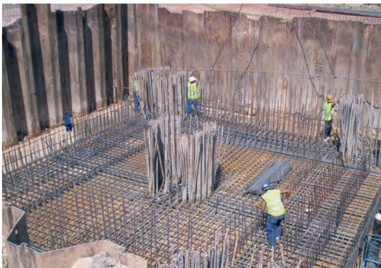
Trabajos de ferrallado de un encepado de 5 pilotes de D=2.000 mm.
