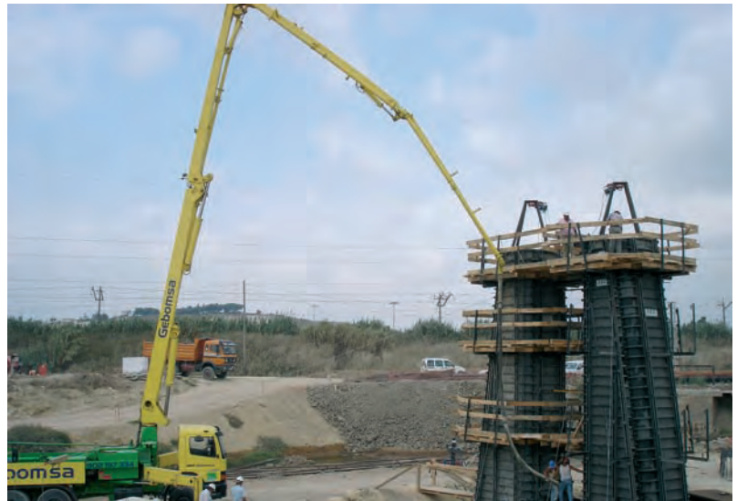
Hormigonado en una fase, abajo, desencofrado.
