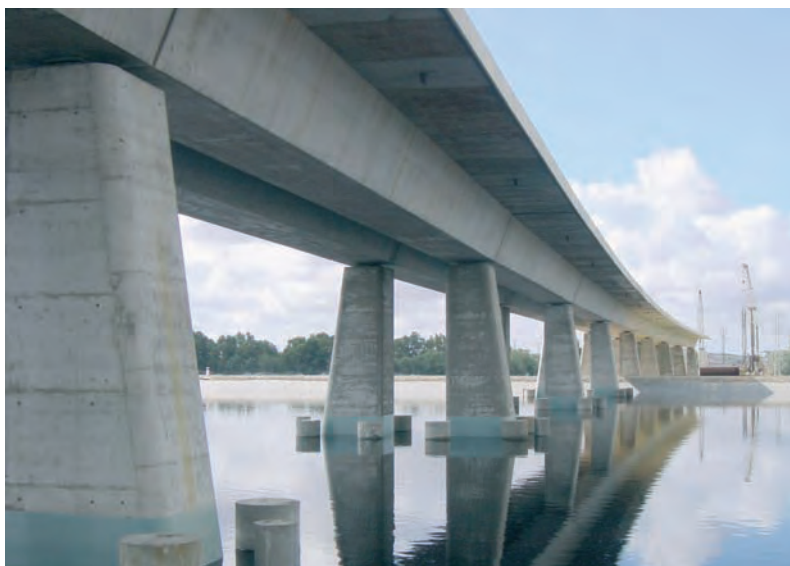
Detalle Tramo 1, cruzando Balsas de Azucarera El Portal.
