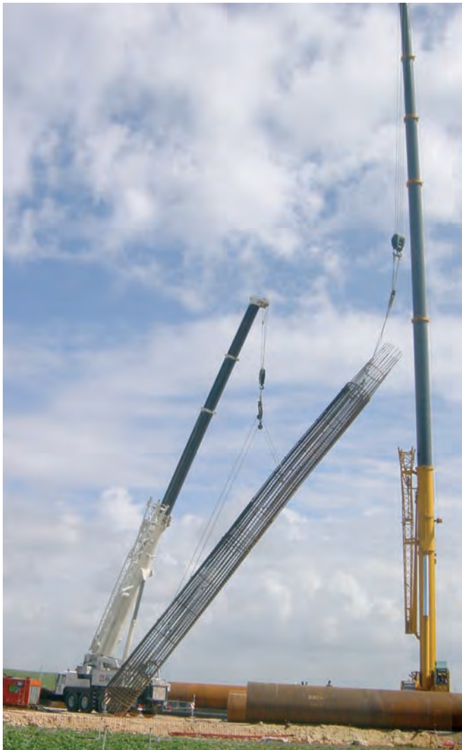
Izado de un tramo de 24 m de ferralla para un pilote de D=2.000 mm. A la derecha, distintas fases del pilotaje del Tramo 6. En primer plano trabajos de perforación y soldadura de tramos de camisa perdida. Al fondo colocación de la jaula de ferralla en un pilote de D=2.000 mm.
