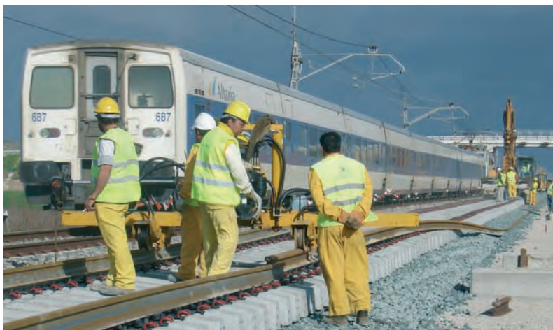
Montaje de vía 1 en los tres últimos kilómetros del tramo. Vía actual en servicio.
