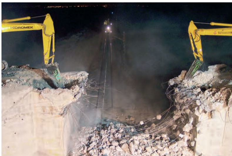
Demolición con corte de catenaria y vía del antiguo Paso Superior de Doña Blanca.
