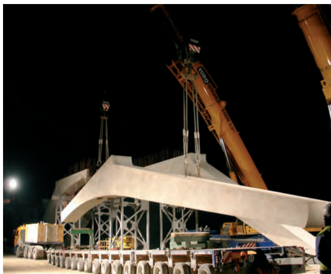
Arriba, montaje de vigas en Tramo 1, dentro de Balsas de Azucarera El Portal. Abajo izquierda, detalle cogida semiarco prefabricado interior, en Tramo 4. Abajo derecha, colocación de semiarco prefabricado interior, en Tramo 6. Se pueden observar las torretas metálicas provisionales y al fondo los caballetes guía de apoyo en las rótulas.
