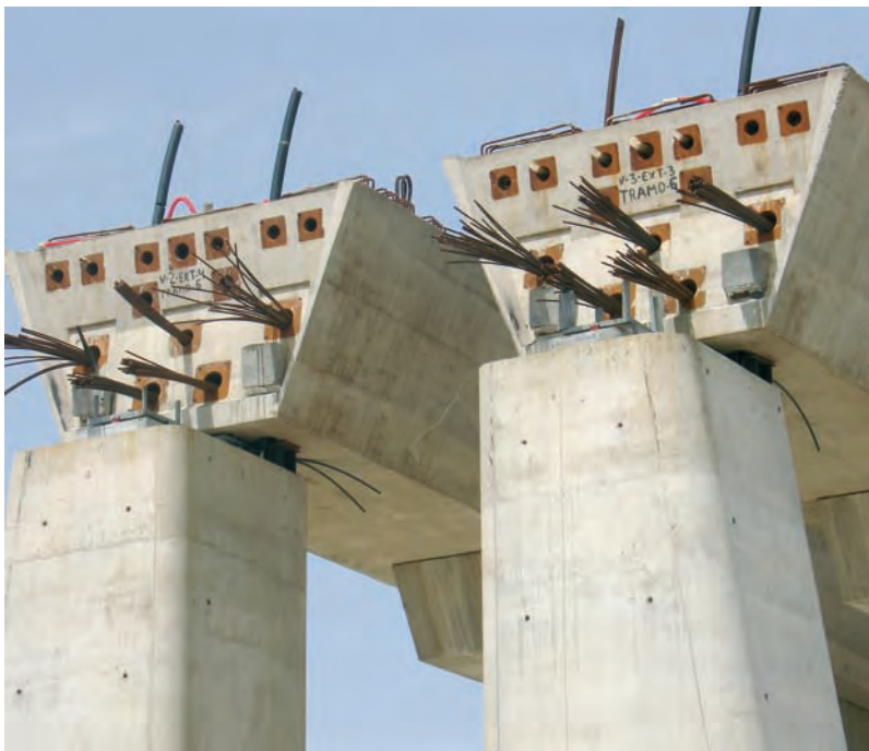
Detalle cabeza viga exterior. Se observan ya enfilados los torones correspondientes al postesado de continuidad que recorre las vigas por su parte inferior. 4 torones de 24 Ø 0,6" y 1 de 18 Ø 0,6".
