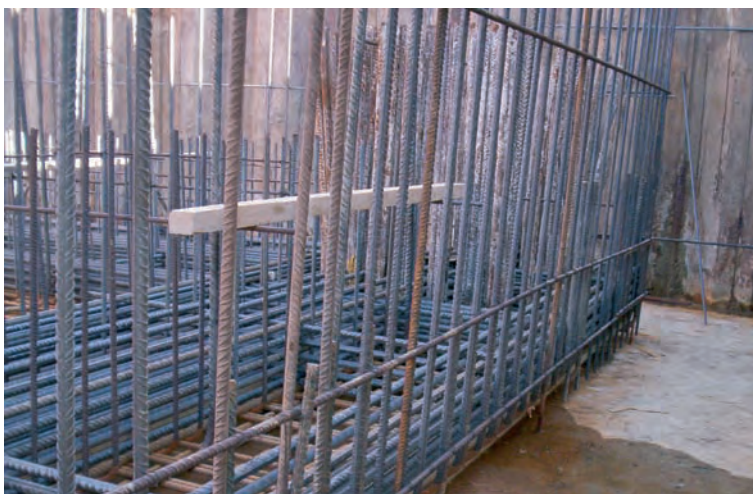
Detalle armado parrilla inferior de un encepado de tramo hiperestático. Hasta 8 capas de D=32 mm.
