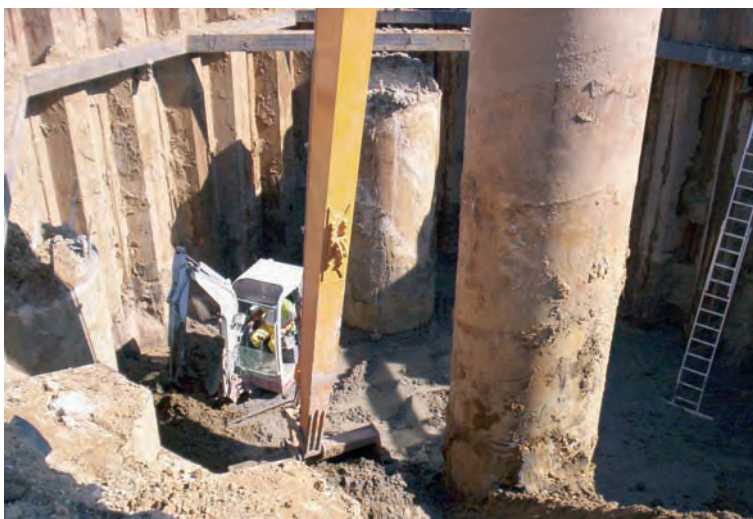
Trabajos de excavación de un encepado, dentro del cauce del Guadalquivir, de 5 pilotes de D=2.000 mm.
