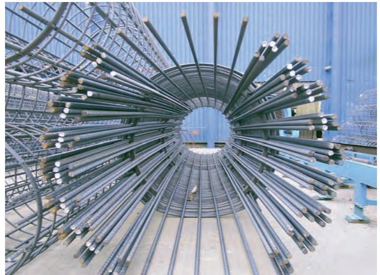
Armado de la cabeza de un pilote D=2.000 mm.
