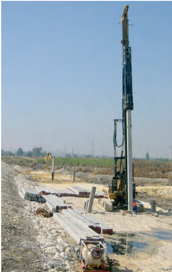
Hinca de pilotes prefabricados en Tramo 1, dentro de Balsas Azucarera El Portal.
