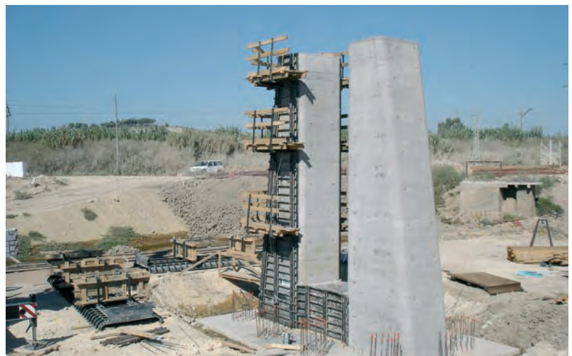
Hormigonado en una fase, abajo, desencofrado.
