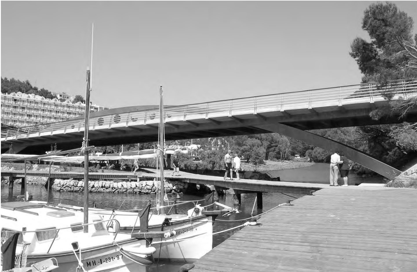
Fig. 1. Vista general del puente sobre el torrente de Algendar/ General view of the bridge over the Algendar freshet.
