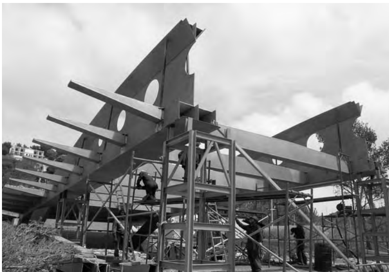
Fig. 15. Montaje de la estructura por tramos/ Assembly of the structure in sections.
