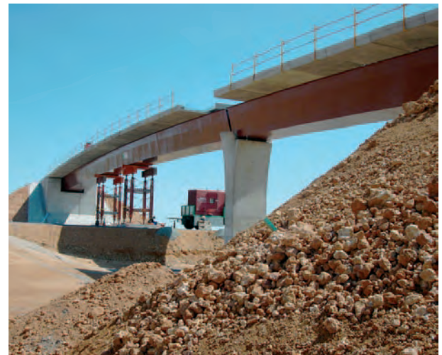
Tramo: Toledo-Consuegra, paso superior de camino.
