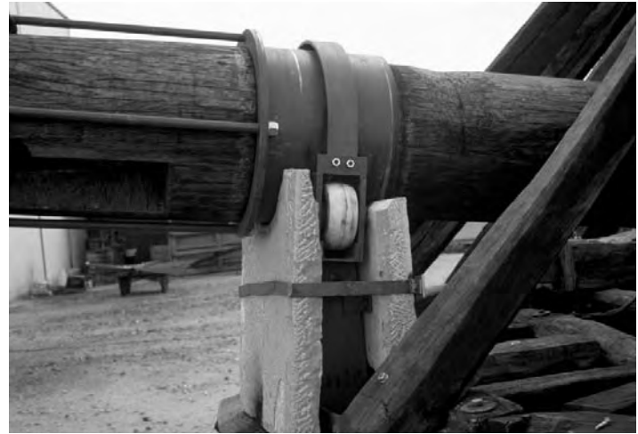
Parte giratoria con el eje y la rueda catalina. A la derecha, detalle del apoyo del eje en la piedra bollega.
