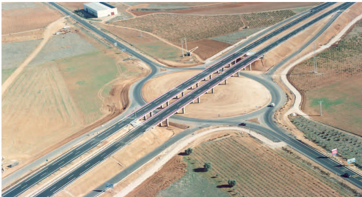
Tramo: Consuegra-Tomelloso. Enlace con la N-420 en Alcazar de San Juan.
