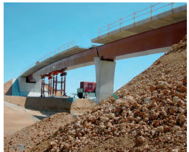
Tramo: Toledo-Consuegra, paso superior de camino.
