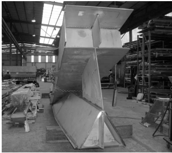
Fig. 7. Vistas del arco y viga longitudinal durante su construcción en taller/ Views of the arch and longitudinal beam during workshop construction.
