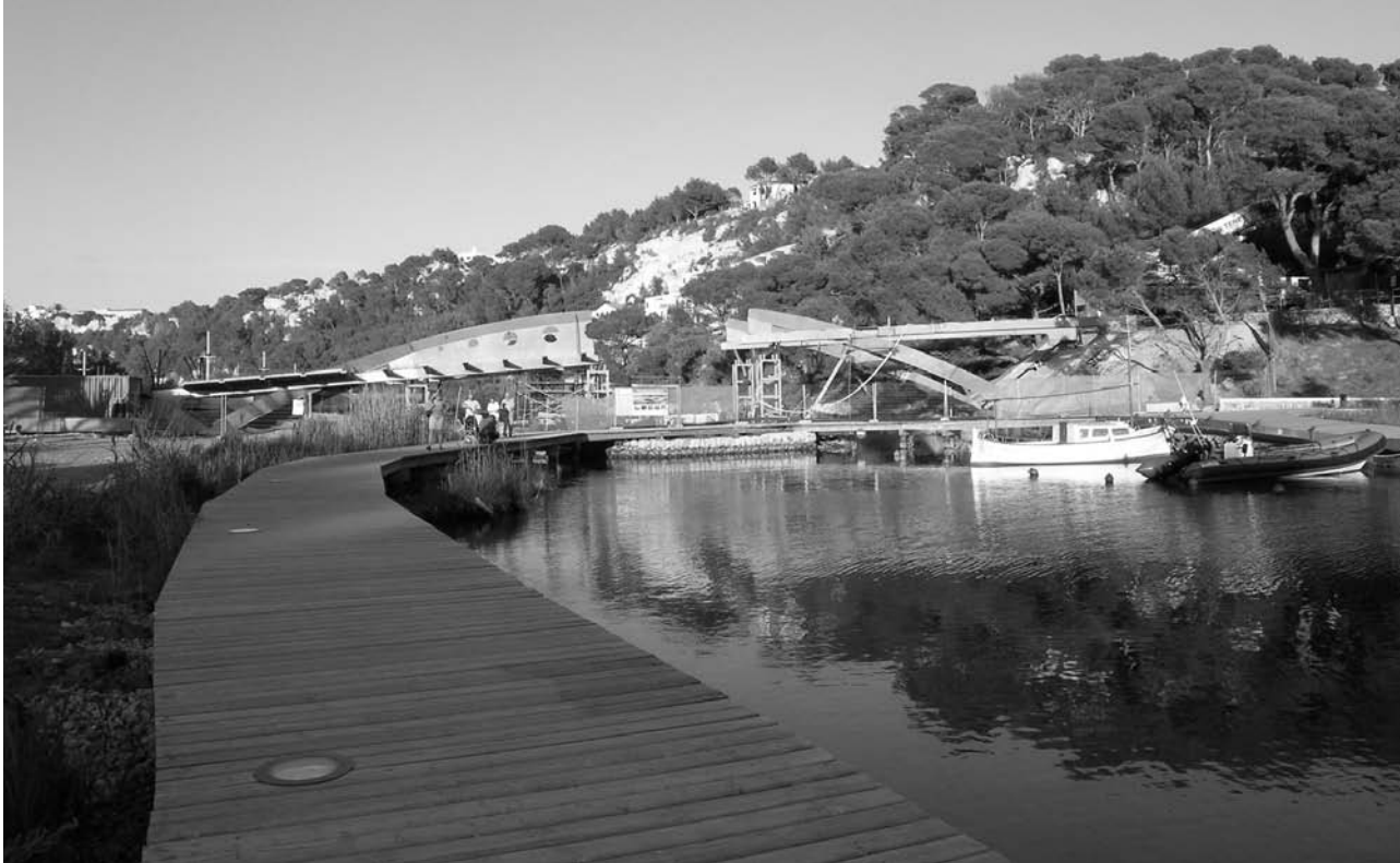
Fig. 16. Montaje de la estructura metálica/ Assembly of the steel structure.
