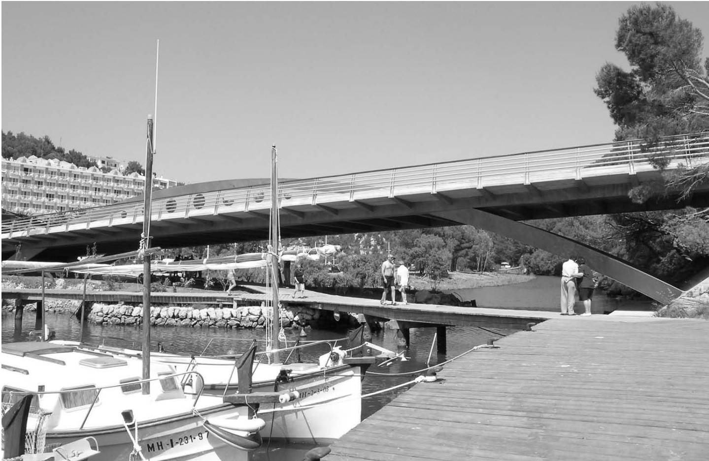
Fig. 1. Vista general del puente sobre el torrente de Algendar/ General view of the bridge over the Algendar freshet.
