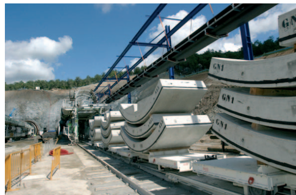
De arriba a abajo. Cabeza de corte Tuneladora 1 Tramontana. Interior del Túnel y dovelas entrando al Túnel.
