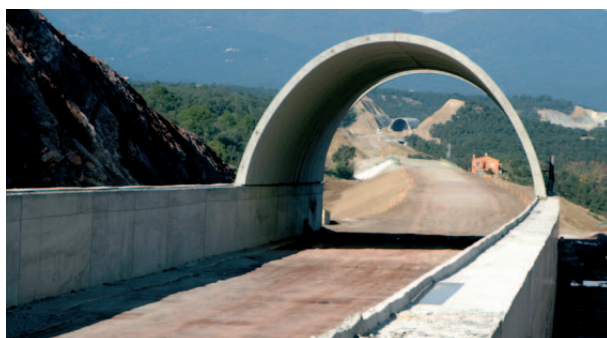
Dispositivos de seguridad. Debajo, Perspectiva de 2 de los falsos túneles.
