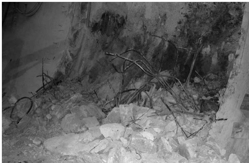
Demolición de las dovelas/Demolition of segments.
