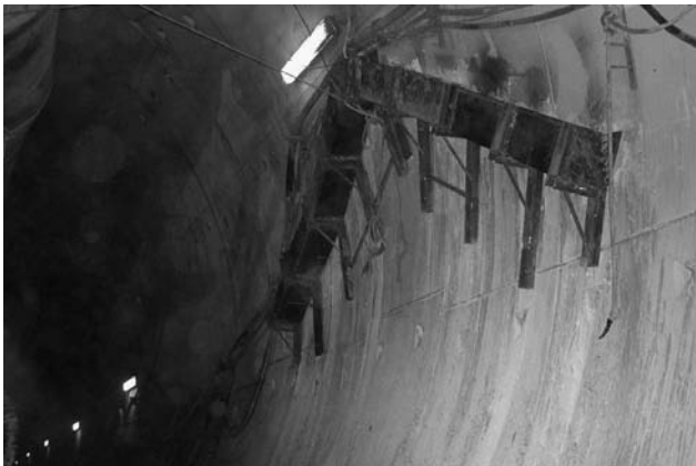
Ejecución de la viga de atado/Forming of tie beam.
