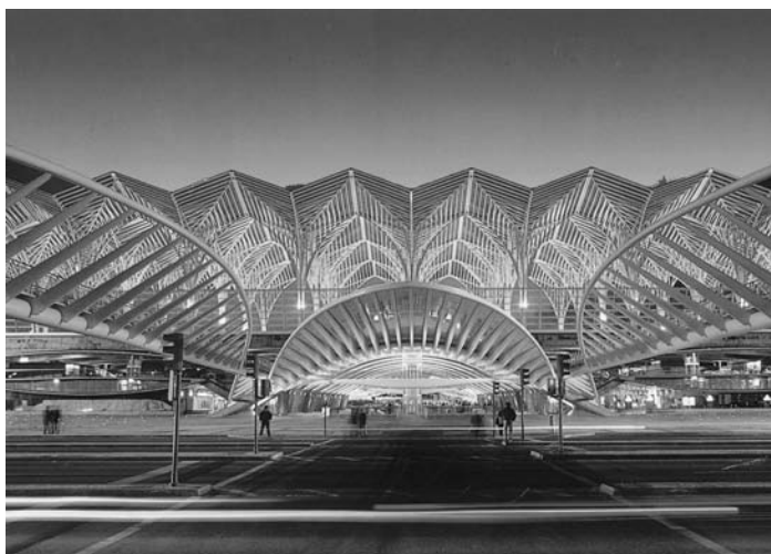
Estación intermodal de Oriente en Lisboa (Portugal).
