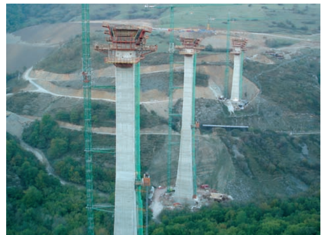
Fig. 11. Ejecución de dovelas "0" del tablero.
