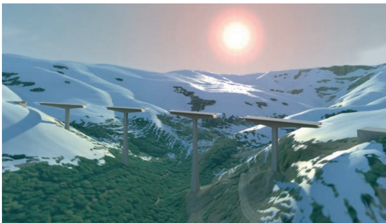
Fig. 10. Ejecución de dovelas de tablero mediante carros de avance.
