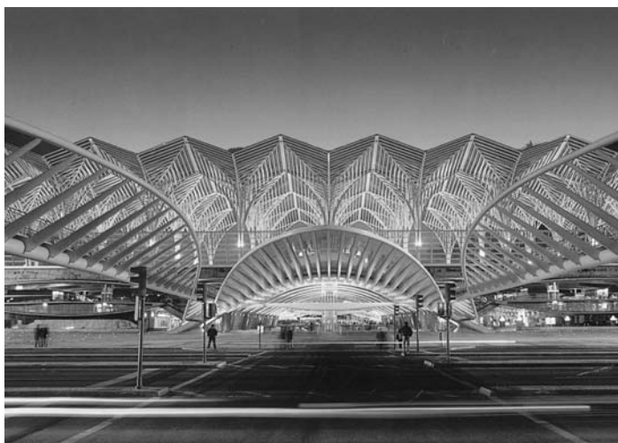
Estación intermodal de Oriente en Lisboa (Portugal).
