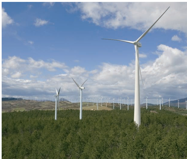
Torre de hormigón de 80 m con aerogenerador de 1500 kW construida en 2005 en el parque de Albar, en Navarra/80 m high concrete tower with 1500 kW wind generator built in 2005 at the Albar wind park in Navarra.
