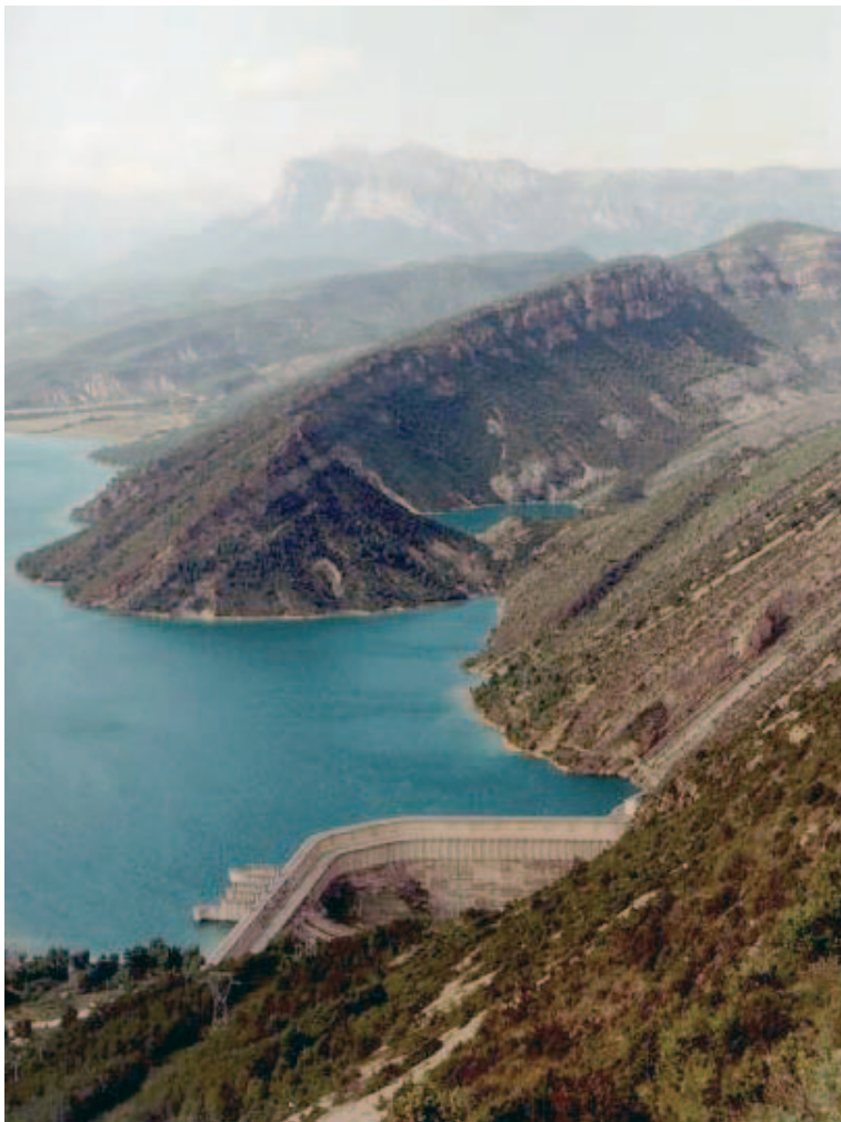
Panorámica aérea de la presa de Mediano, sobre el Cinca. En la sucesión calcárea que tan bien se aprecia a vista de pájaro se hubo de buscar la ubicación de la central, en las profundidades del macizo del estribo izquierdo, en unas calizas con alveolinas muy sanas. Aguas abajo -no se llega a ver- el río se encaja en las umbrías del estrecho de Entremont. Por arriba, por el contrario, el valle se abre en las margas azules eocenas, donde se ubicaba el anegado pueblo que da nombre al embalse. Foto MMA.
