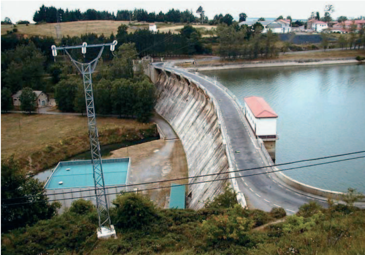
La modesta presa de cabeza del Ebro, cercana a Reinos, que regula una cuenca de apenas 500 km 2 del joven cauce se levanta 34 metros sobre cimientos. En un estrecho portillo (el desarrollo por coronación es ligeramente mayor de 200 m) es capaz sin embargo de anegar un área de más de 6.000 Ha, y genera un cubo de 540 Hm 3 . Foto MMA.
