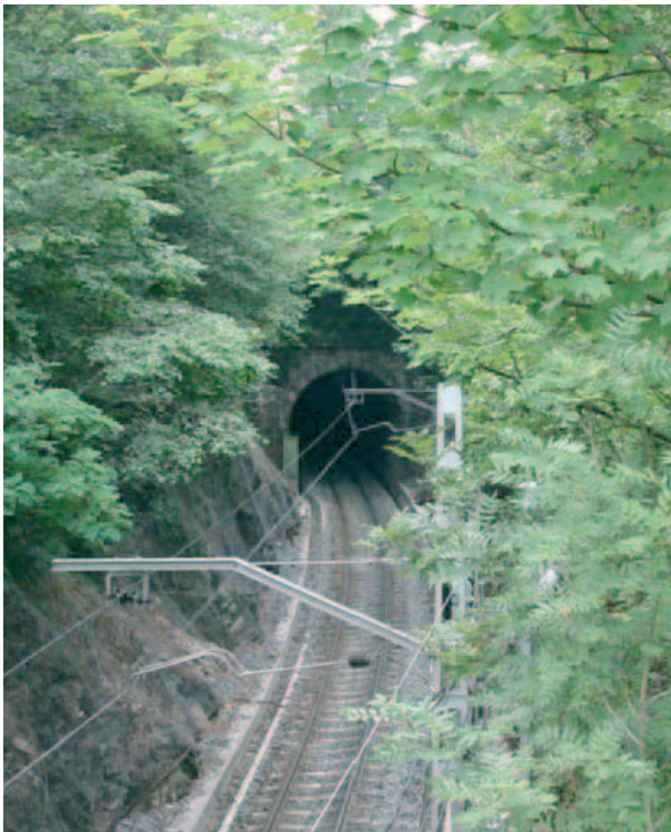
Fig. 14. Línea ff.cc. bajo viaducto de Lasarte.
