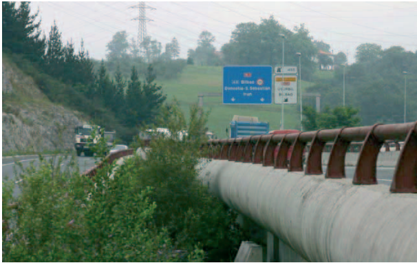
Fig. 13. Zona de ubicación de una pila en viaducto de Lasarte.
