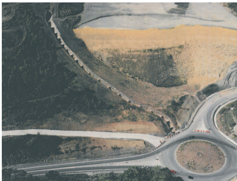
Fig. 12. Bajante escalonado tipo.
