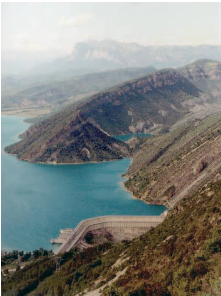
Panorámica aérea de la presa de Mediano, sobre el Cinca. En la sucesión calcárea que tan bien se aprecia a vista de pájaro se hubo de buscar la ubicación de la central, en las profundidades del macizo del estribo izquierdo, en unas calizas con alveolinas muy sanas. Aguas abajo -no se llega a ver- el río se encaja en las umbrías del estrecho de Entremont. Por arriba, por el contrario, el valle se abre en las margas azules eocenas, donde se ubicaba el anegado pueblo que da nombre al embalse. Foto MMA.
