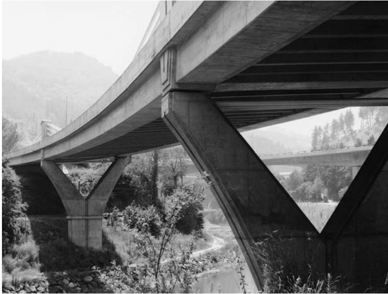
Fig. 3. Aspecto de la parte inferior del tablero.
