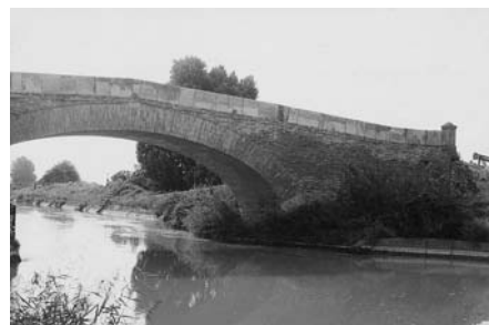
Puente de Cortés en el Canal Imperial de Aragón.
