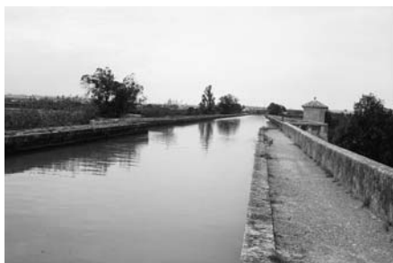
Acueducto sobre el Jalón, en el Canal Imperial de Aragón.
