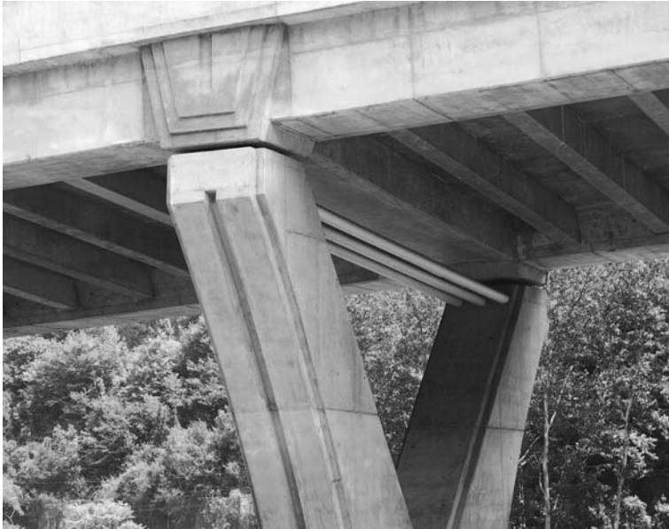
Fig. 5. Detalle de la zona de apoyo del tablero sobre una de las pilas. La imagen muestra los tubos de atirantamiento transversal.
