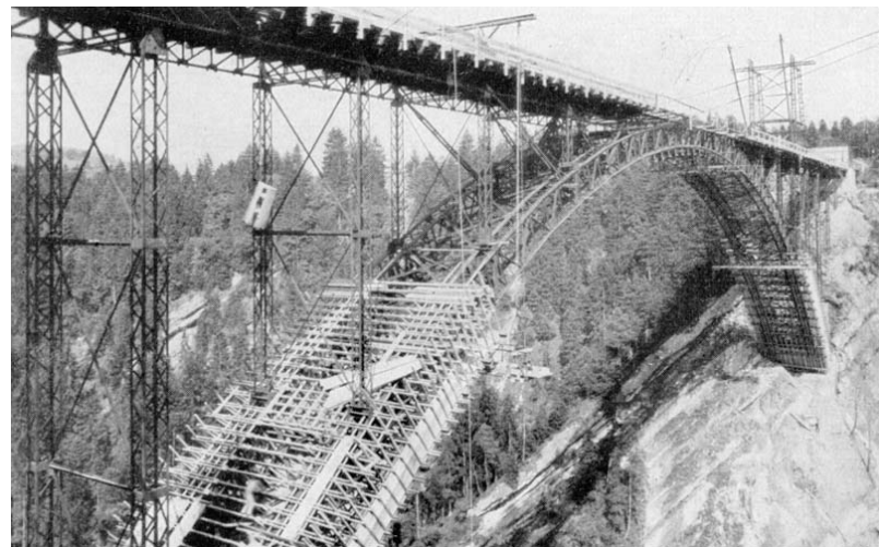
Fig. 11. Puente de Echelsbach en construcción. (Duell y Gerhart 1929, 57).
