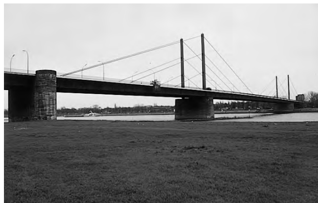
Fig. 34. Nordbrücke sobre el Rin en Dusseldorf. Alemania. Hein Lehmann y Leonhardt y Andra Ings. F. Tamms Arq. Luz 260 m.
