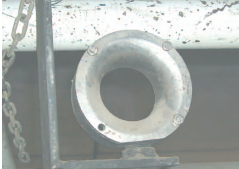
Fig. 10. Detalle de un difusor de aire comprimido para la remoción del aire en zonas de calma dentro del escudo/Close up of a compressed air diffuser for air conditioning in trapped areas within the shield.
