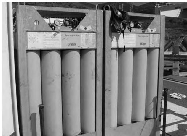
Fig. 11. Detalles de una de las cámaras de supervivencia /Details of one of the survival cabins.
