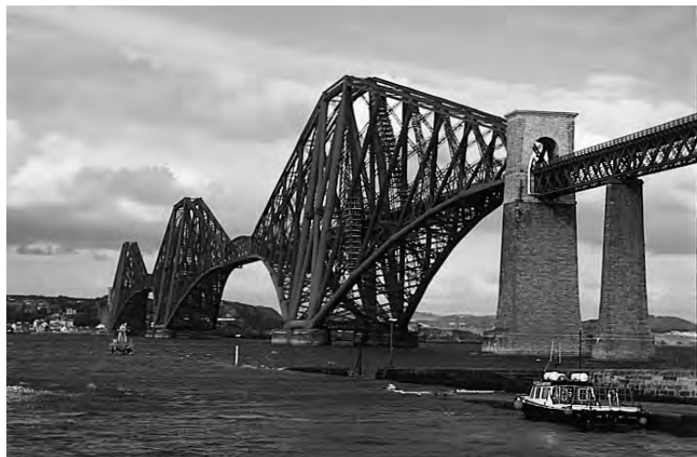
Fig. 24. Puente del Firth of Forth, Escocia. 1890. J. Fowler y B. Baker. Luz 521 metros.
