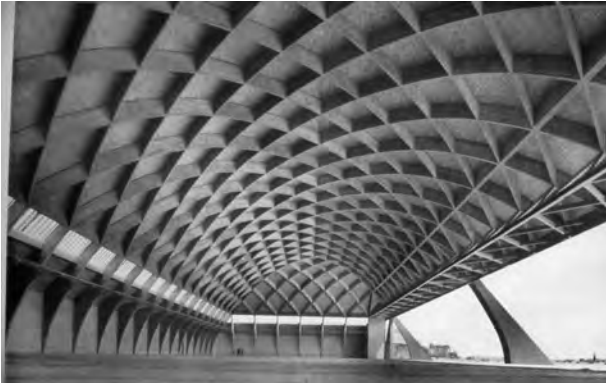
Fig. 40. Hangar de Orvieto. Italia. 1935. Pier Luigi Nervi.
