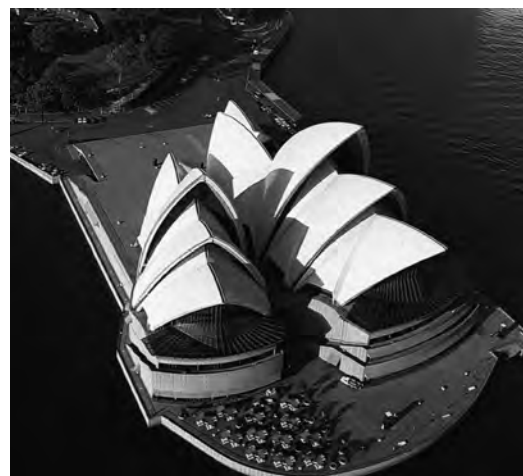
Fig. 8. Ópera de Sydney. J. Utzon Arq. Over Arup & Partners Ings. Fig. 9. Cúpula de Santa María del Fiore. Florencia. F. Brunelleschi. S. XV.
