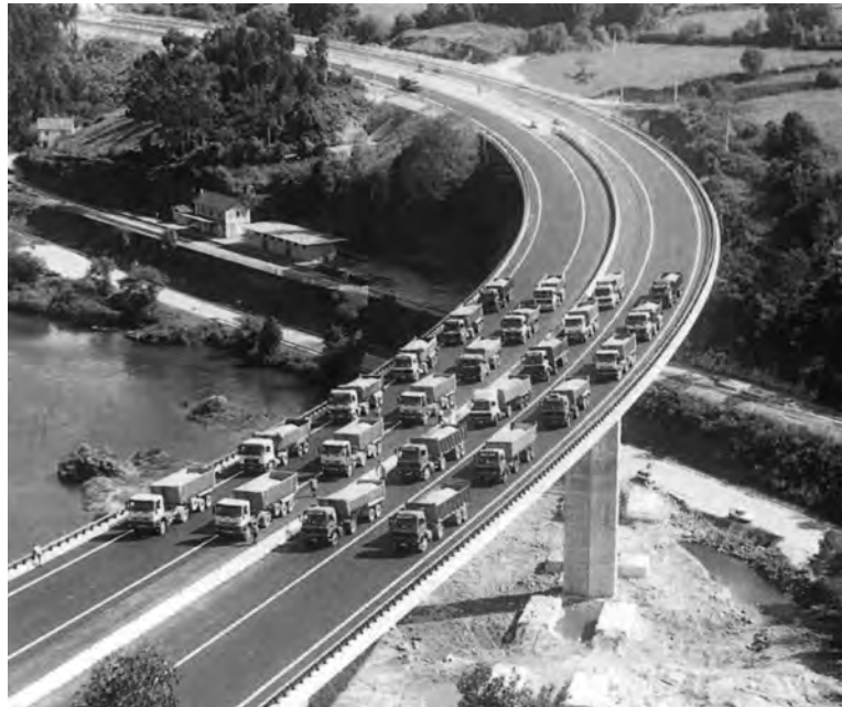
Fase prueba de carga (1). Cortesía Geodisa.
