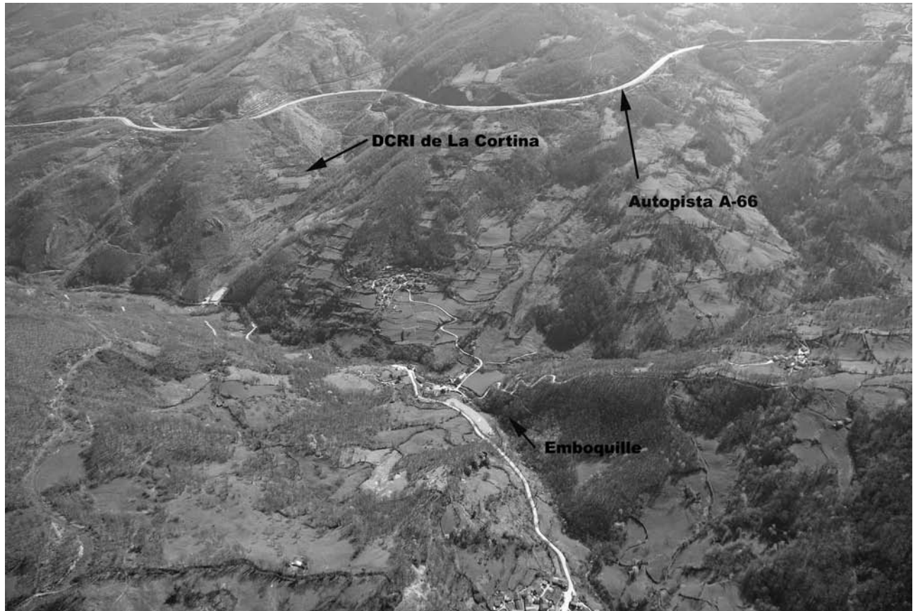
Fig. 12. Fotografía de la zona del emboquille Norte (Asturias)/Aerial photograph of the north portal area (Asturias).
