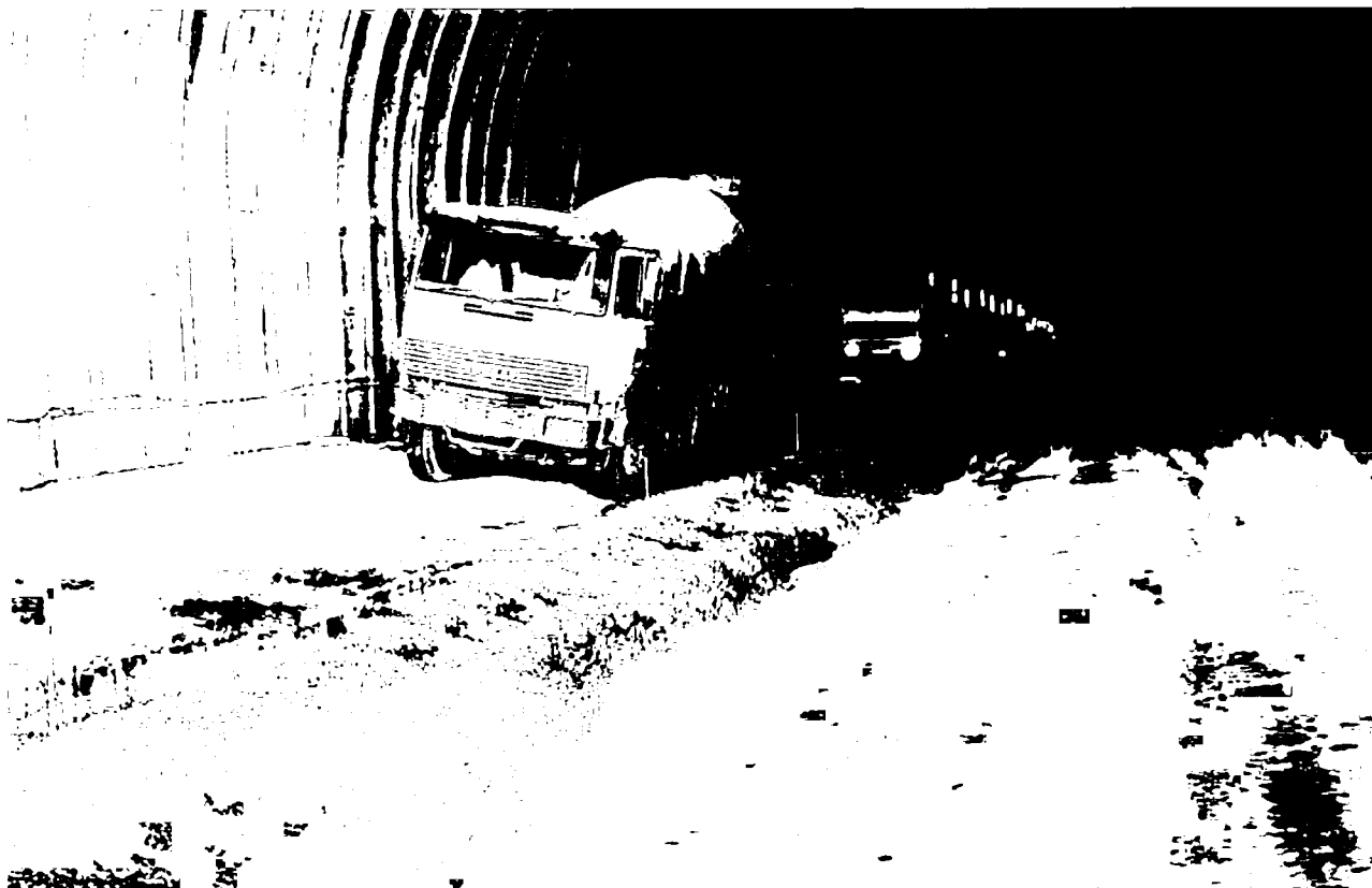
Túnel de Álora
