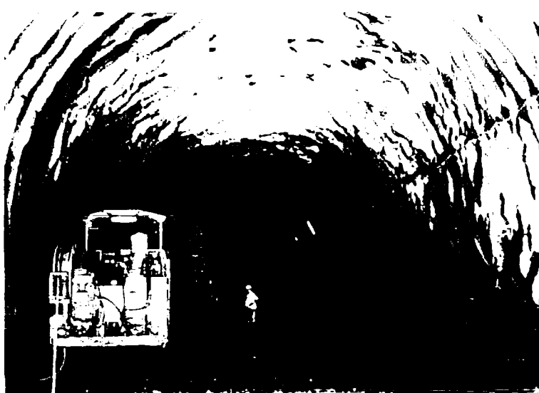
Túnel de Álora
