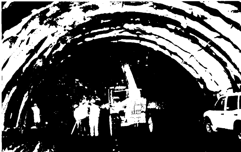
Cerchas del Túnel de Álora.
