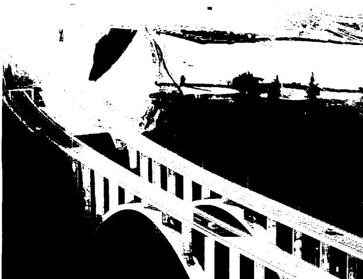
Abajo izda, Viaducto sobre el río Cieza. A la dcha., proceso de avance del arco y tablero.
