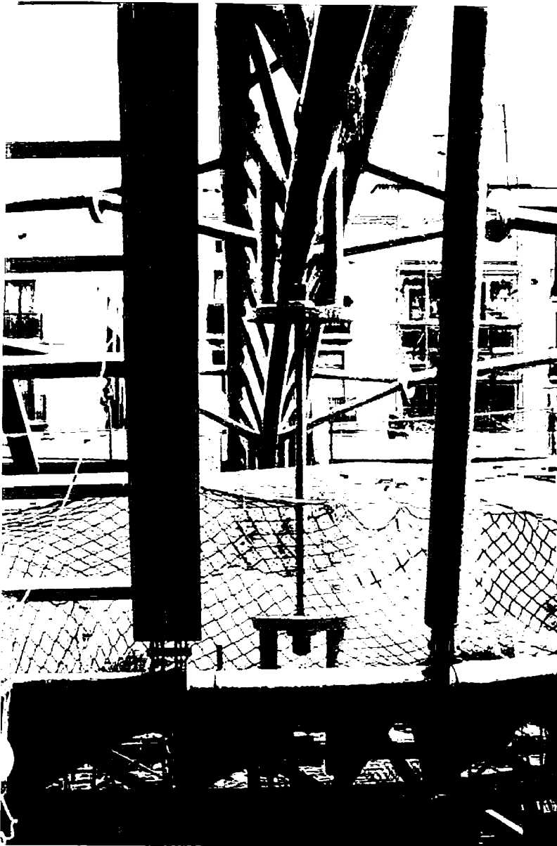
Fig. 5. Péndolas y unión a arcos y vigas en uve.
