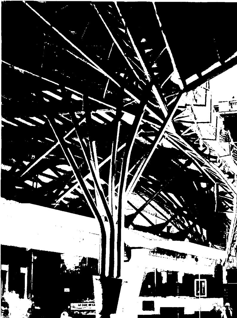
Fig. 12. Pilar en plaza Joan Capri y unión de tres vigas metálicas
