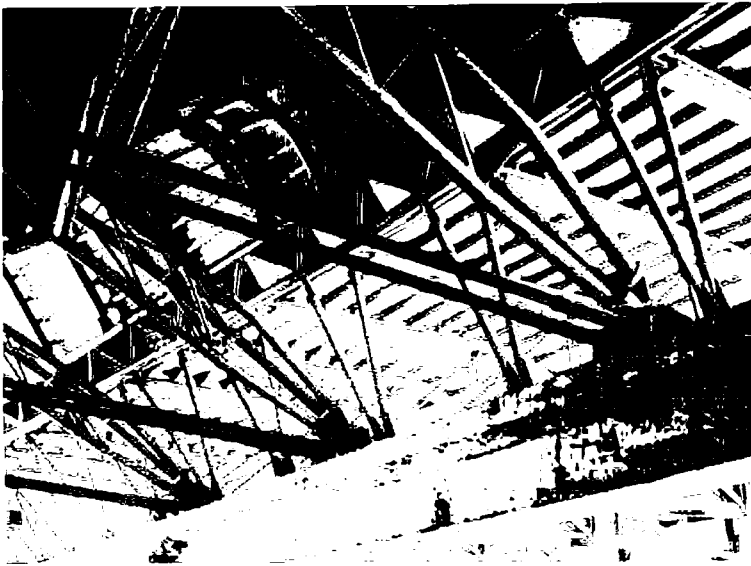
Fig. 3. Apoyo de los grandes arcos de acero y atriantamiento.
