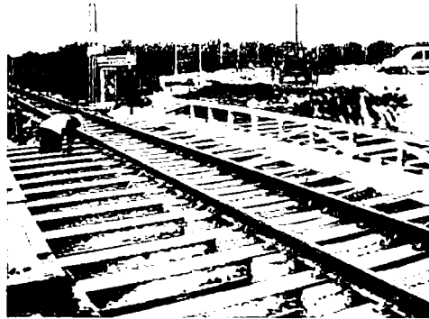
Fig. 4. Vista general de la estructura de sostenimiento/ General view of support structure.
