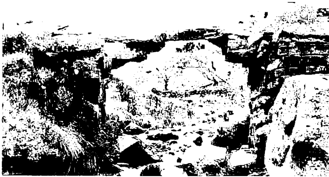
Fig. 1. Falso arco con piedras en voladizo.
