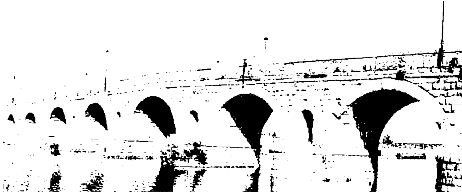
Fig. 3. Puente romano en Mérida. A la dcha. fig 4, puente medieval en Frias (Burgos).
