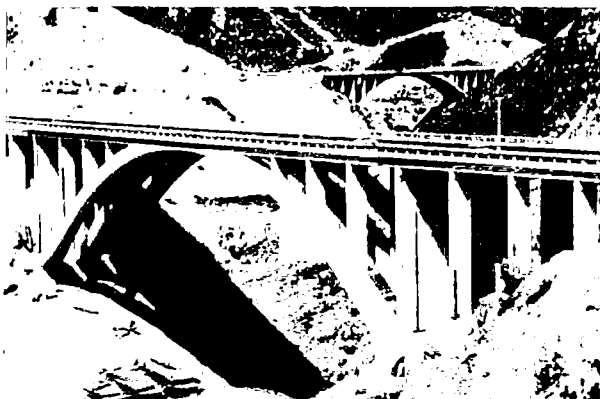
Fig. 18. Uno de los arcos de la Güaira. A la dcha. fig 19. Cimbra de los arcos de la Güaira.
