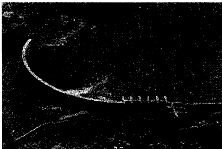
Fig. 6. A la izda, presa auxiliar de El Tenebroso, a la dcha., canal de desagüe de avenidas y aguas turbias. Fotografía Archivo CYII.
