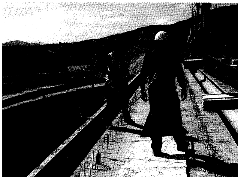
Una protección colectiva: "línea de vida" y arneses en la construcción de tableros de puentes (¿debe quedar constituida por una o varias unidades 'normales' de obra?).
