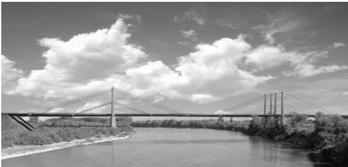
Fig. 9. Puente sobre el Ebro Diseño: Research & Concrete, S.A. – Intecsa-Inarsa.
