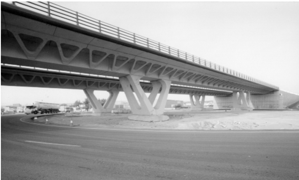
Fig. 7. E-28 del Cuarto Cinturón de Zaragoza sobre la N-232 Diseño y Proyecto: Research & Concrete, S.A. – Intecsa-Inarsa, S.A. Ejecución: Ronda Sur UTE (Sacyr – Necso) - Alvisa.
