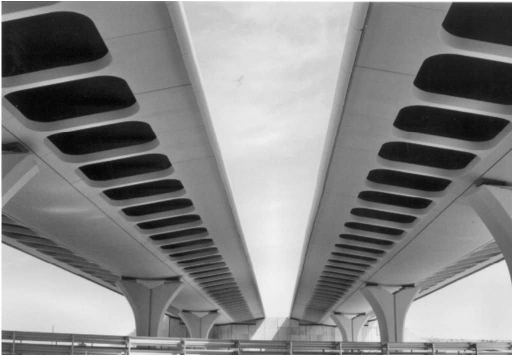
Fig. 6. Puente del Tercer Cinturón de Zaragoza sobre la A-2 Diseño y Proyecto: Research & Concrete, S.A. – Sers, S.A. Ejecución: Ronda Hispanidad UTE (FCC – ACS) - Alvisa.
