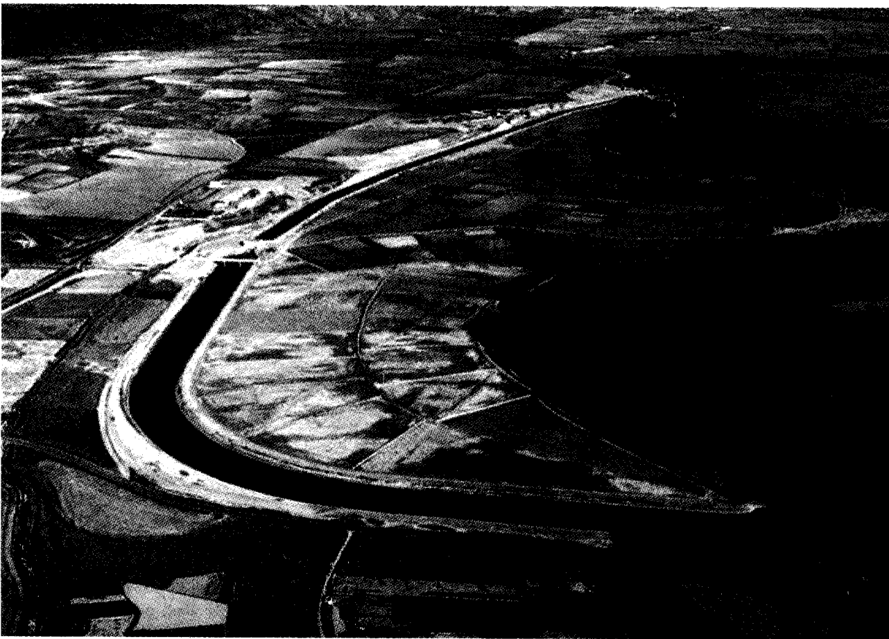
Central de Santacara, en el río Aragón, construida en 1998/ Santacara Power Station on the River Aragón, built in 1998.
