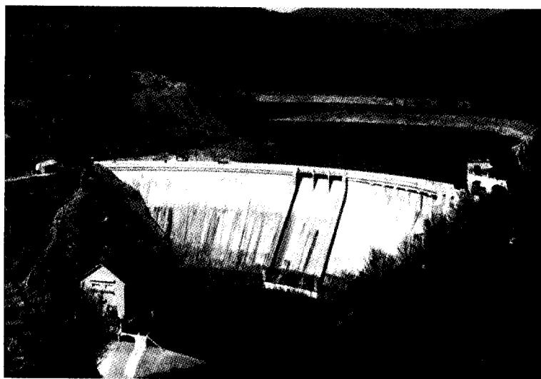
Presa y Central de Irabia en construcción en 1945. A la derecha, Acueducto de la Central de Betolegui, en construcción. en 1945/ Irabia Dam and Power Station under construction in 1945. To the right, Construction of the aqueduct to the Betolegui Power station in 1945.
