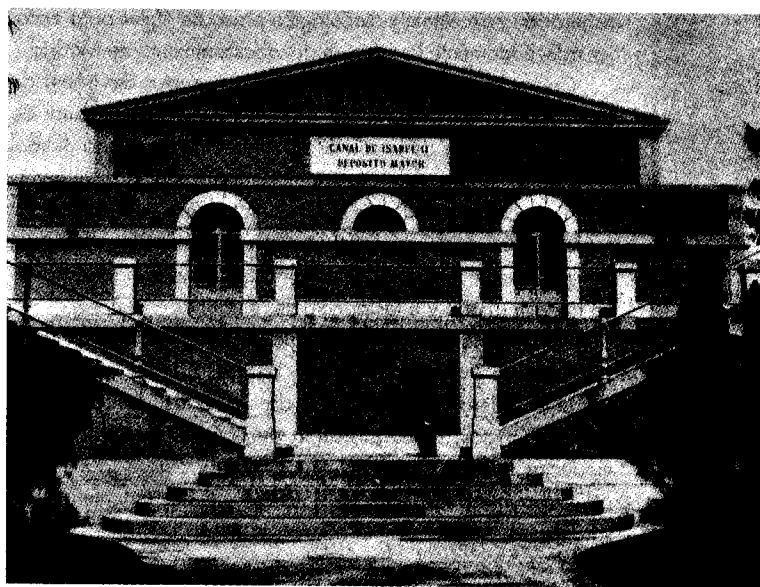
Vista general del segundo depósito.
