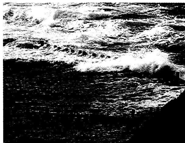
Figuras 34 y 35. Hilera de cilindros de seguridad en la charca de Roque Prieto: amortiguación y dispersión de los flujos de rebase de las olas.
