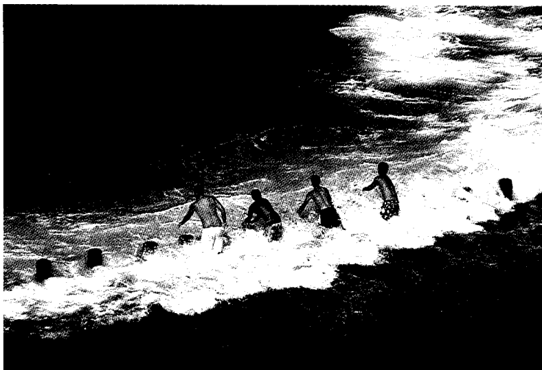
Figura 33. Hilera de cilindros de seguridad en la charca de Roque Prieto: amortiguación y dispersión de los flujos de rebase de las olas.
