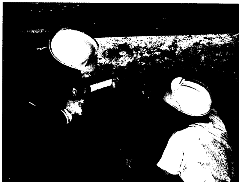
Microcosidos e inyección de resina.
