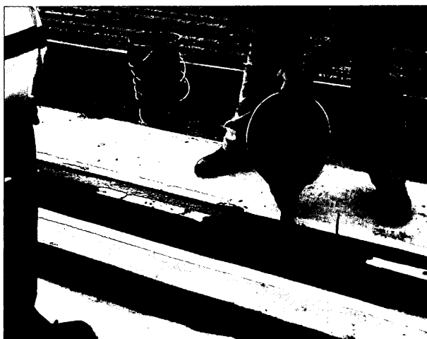
Figura 7. Vertido de corkelast en el sistema Edilon.
