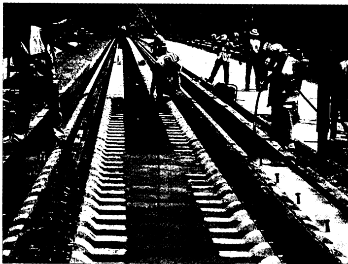
Figuras 9 y 10. Hormigonado y alineación de carril en el sistema Rheda 2000.
