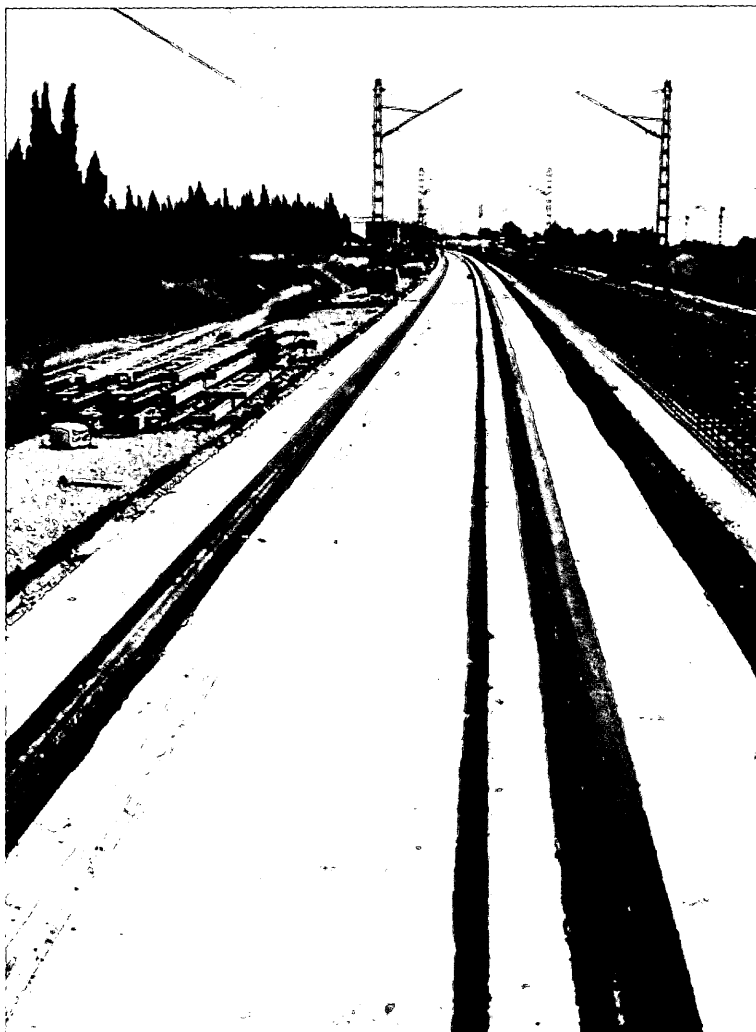
Figura 6. Vista de la vía Edilon acabada.
