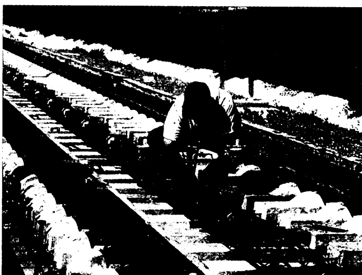
Figuras 9 y 10. Hormigonado y alineación de carril en el sistema Rheda 2000.
