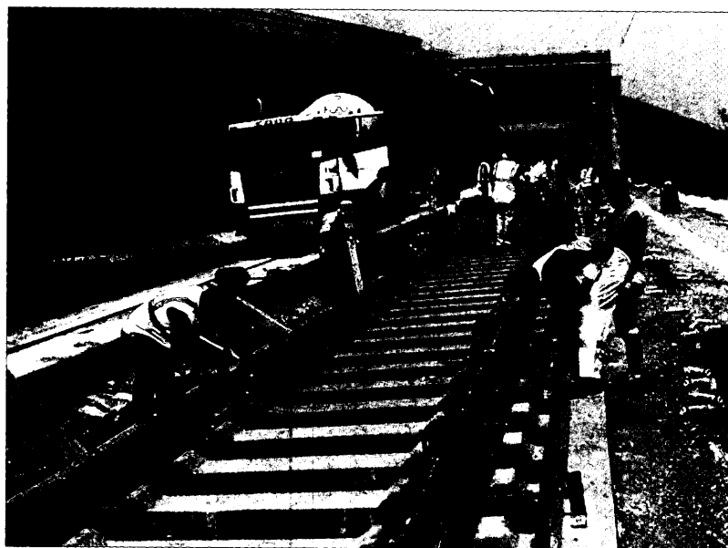
Figura 8. Alineación de carril en el sistema Rheda Dywidag.
