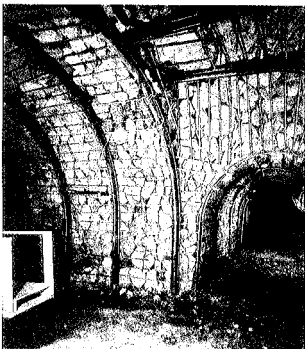
Entranque entre la galería principal y uno de los anchuramos donde se sitúan las piscinas subterráneas. Puede apreciarse la diferencia de tamaño entre ambas secciones y la complejidad de la unión resuelta mediante un parralado. En primer lugar y a la izquierda está la escalera, provisional y de madera, de acceso a la piscina. La sección de estos anchuramos es de 3x3 m de sección, 10 m de longitud y la salera se ha rebajado 2m sobre el piso de la galería.
