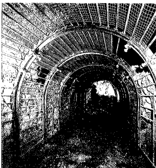
Interior de la galería de Recuperación de la Fuente Santa en un tramo donde afloran las caladas masivas en la mitad superior mientras que la inferior esta revestida con piedras grandes que evitan la fluencia de las escorias de pequeña tamaño. Los arquetes de color verde oscuro están separados un metro y se encuentran unidos por redondos soldados. De esta forma toda la estructura, en forma de gusano articulada, tiene la virtud de permitir movimientos que son necesarios para acomodarse al todavía asentamiento de estos terrenos recientes sobre un fondo marino antiguo.
