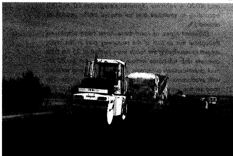
Fotografía 5. Puesta en obra de la mezcla con betún de alto contenido en caucho. Es similar a la de cualquier mezcla/Photograph 5. Paving process of high rubber content asphalt mix identical to that of conventional mixes. Fotografía 6. Macrotextura conseguida en la autopista A-7. Se obtuvo un valor de 1,7 mm de profundidad del círculo de arena (NLT-335)/Photograph 6. Macrotexture of the A.7 motorway. Texture depths of 1.7 mm were obtained according to sand patch test (NLT - 335).
