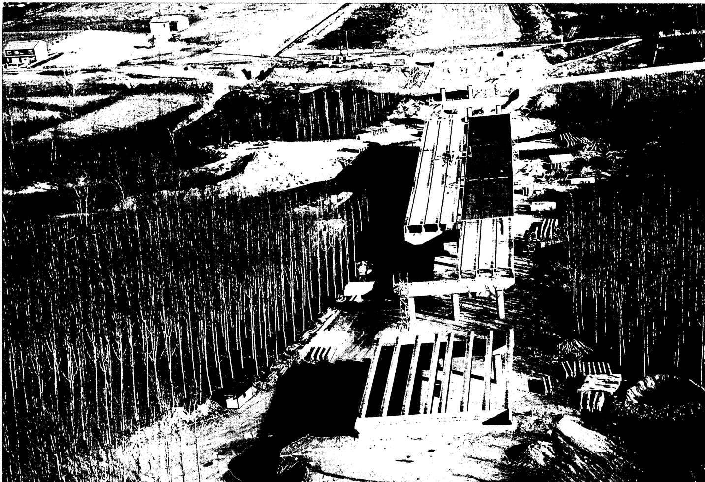
Viaducto sobre el Río Órbigo.
