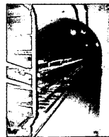
GALERIAS VISITABLES: Galerías de servicio abovedadas.
