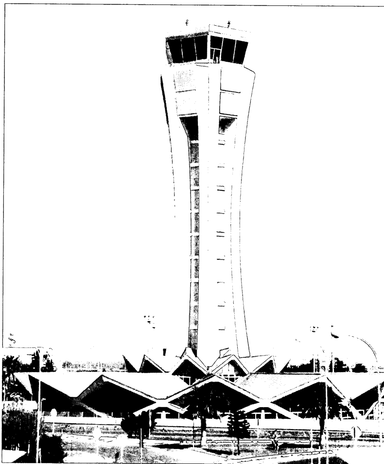
Torre de control del aeropuerto de Málaga.
