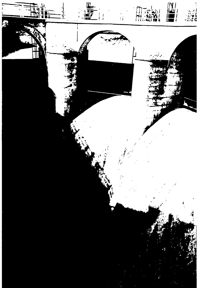
Fotografía 5. Vista de las compuertas del aliviadero.
