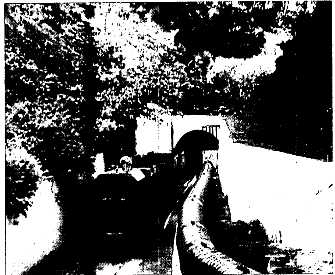
Pesadora de aguas de una galería de Tenerife. Se trata de un ingenio que reparte todo el caudal en tantas partes como acciones se hayan vendido. Se puede observar (a la izquierda), un compartimento que representa las acciones liberadas, aquellas que están exentas de pago y que detraen directamente del caudal total. En la fotografía de la derecha se ve la boca de una galería de Tenerife y la locomotora usada para las labores de perforación.
