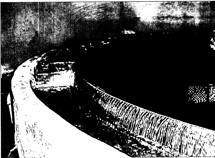
Pesadora de aguas de una galería de Tenerife. Se trata de un ingenio que reparte todo el caudal en tantas partes como acciones se hayan vendido. Se puede observar (a la izquierda), un compartimento que representa las acciones liberadas, aquellas que están exentas de pago y que detraen directamente del caudal total. En la fotografía de la derecha se ve la boca de una galería de Tenerife y la locomotora usada para las labores de perforación.
