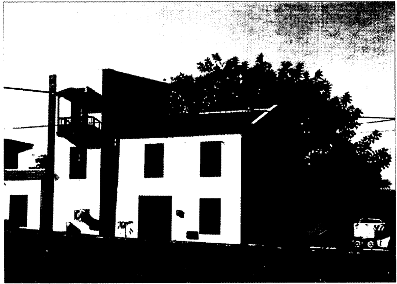
Desaladora mimetizada, por sus grandes dimensiones, en una ermita. A la derecha, edificio que alberga el pozo de Los Padrones. En la torre cuadrada está el pórtico de nueve metros y el ala mas baja el winche y las oficinas de explotación.
