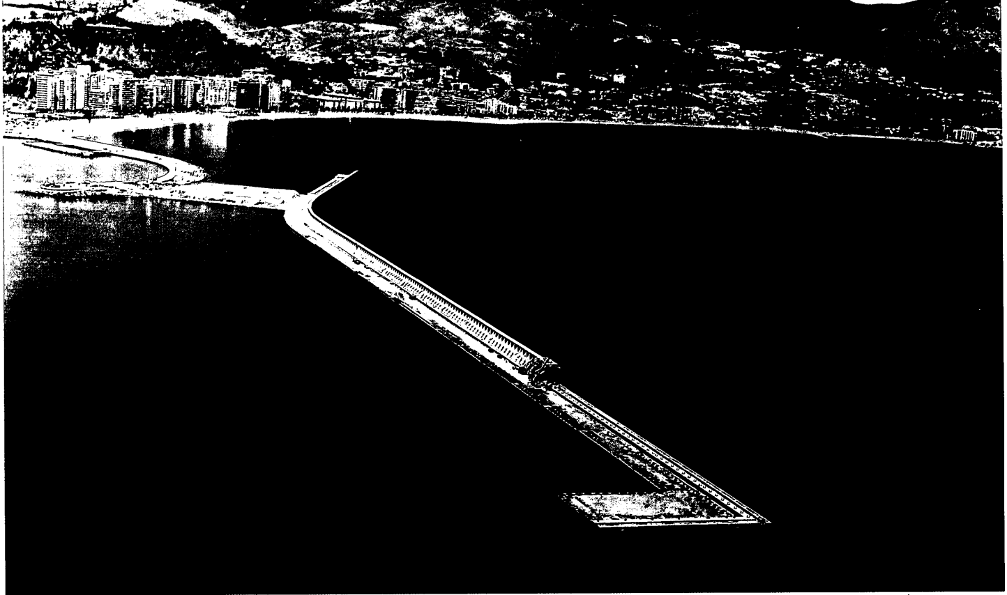
Ejecución del espaldón del dique de Levante.
