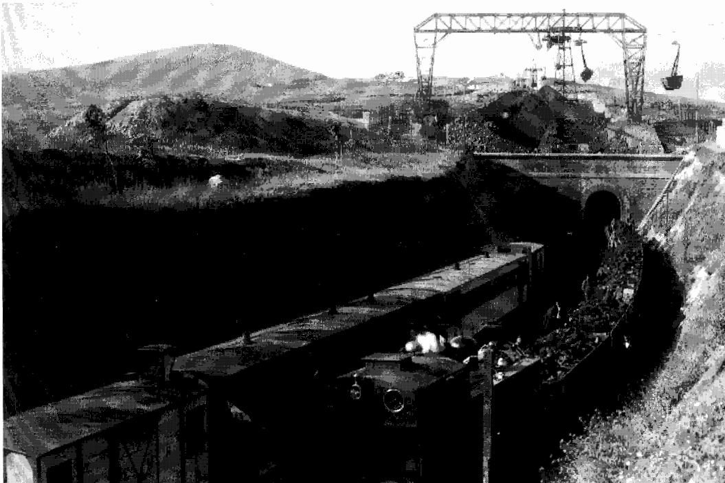
Foto 1. Construcción del depósito de minerales para cargar en los trenes de la Compañía Española de Minas del Rif. 1911. Fuente: Archivo General de Palacio, n o inv. 10172970. Abajo, foto 2. Transporte del mineral de hierro de la Compañía Española de Minas del Rif desde el depósito regulador. 1918. Fuente: Biblioteca de Palacio, n o inv. 10162418.
