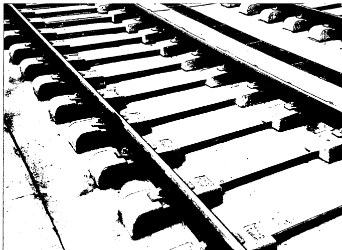
Estación de Santa Justa (Sevilla). Vía en placa tipo Stedef. Abajo detalle de vía en placa tipo Stedef con sujeción Nabla.
