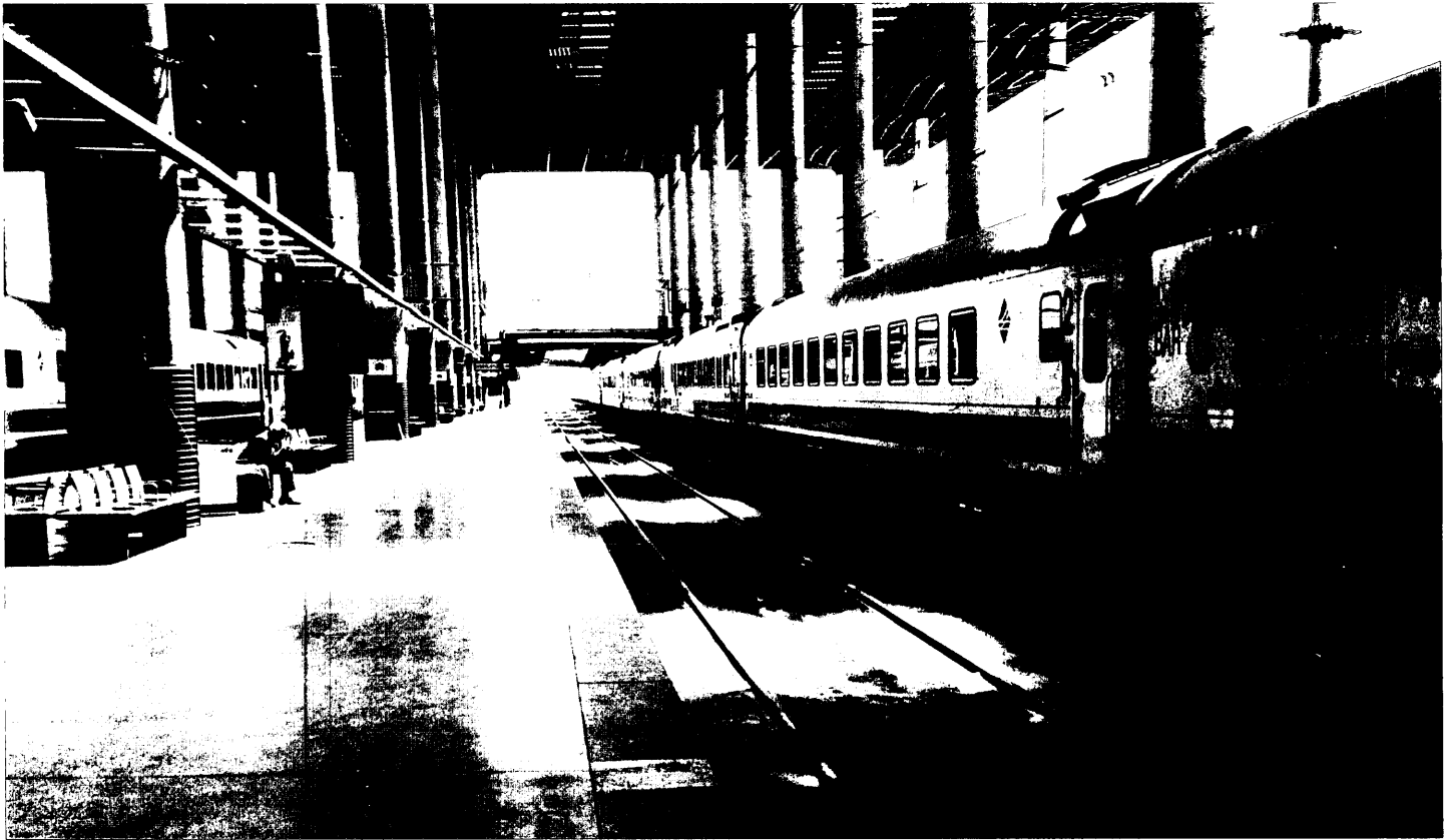
Estación Puerta de Atocha (Madrid). Carril embebido en Corkelast.
