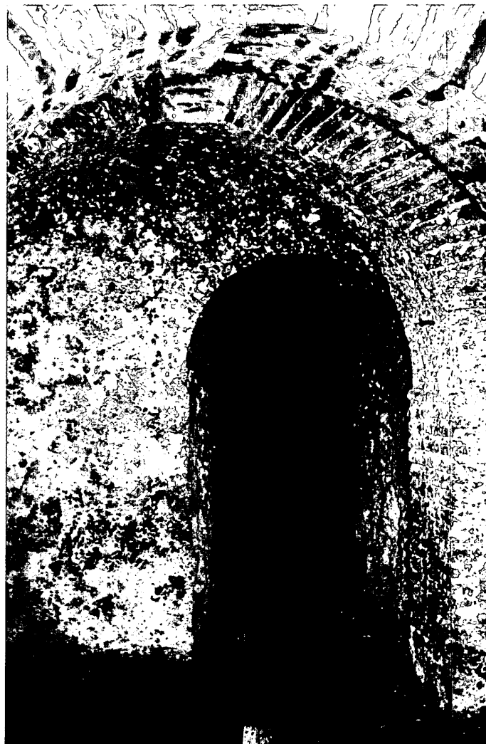
Madrid estuvo abastecida hasta mediados del siglo XIX por medio de una red de galerías subterráneas de origen árabe que llegaron a alcanzar 120 km de longitud. Bajo la ciudad existía un complejo sistema de arcas o cambijas (para el reposo y decantación del agua) y ramales de distribución.
