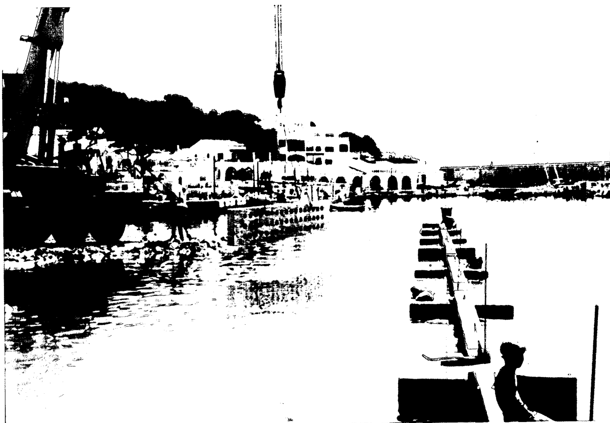
Figura 4. Muelle filtro. Sistema filtrante instalado. Figure 4. Filter Wharf. Installed filtering system.
