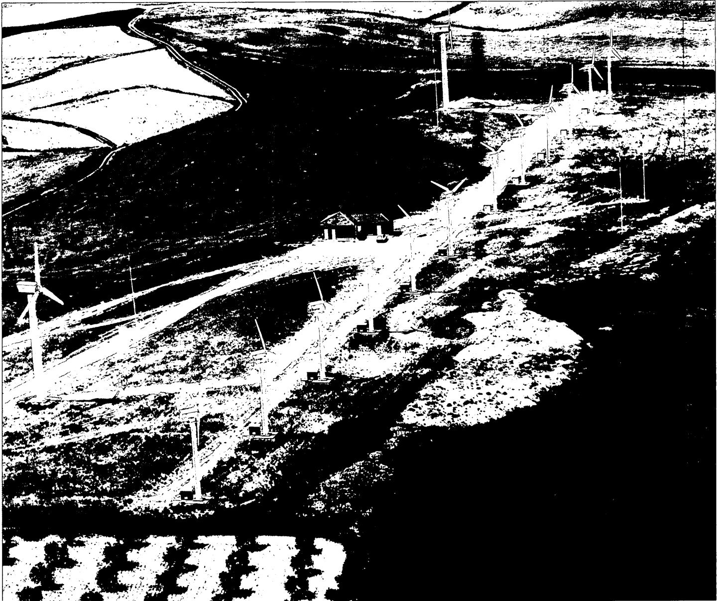
Parque eólico de La Muela (Zaragoza).
