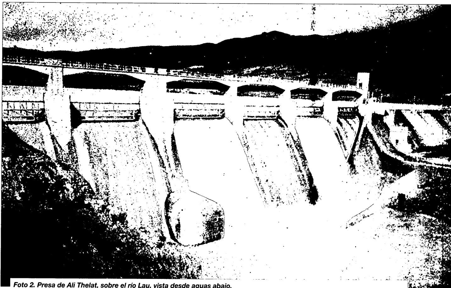
Foto 2. Presa de Ali Thelat, sobre el río Lau, vista desde aguas abajo.
