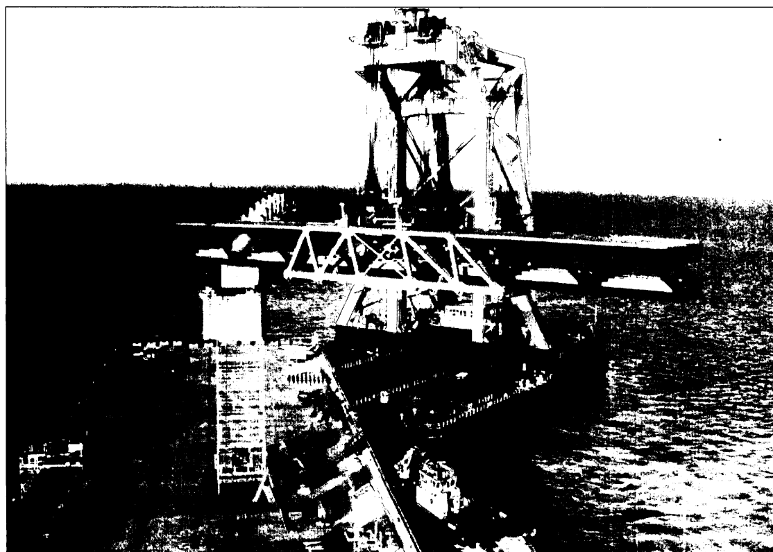
Montaje de uno de los tramos.
