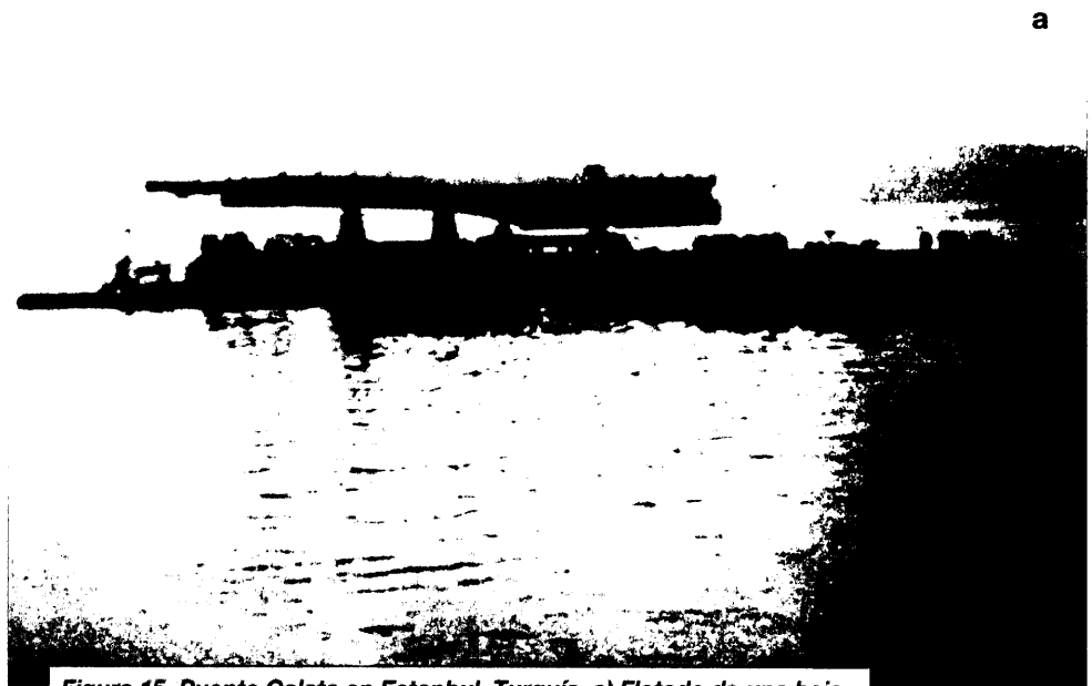
Figura 15. Puente Galata en Estambul, Turquía. a) Flotado de una hoja. b) Secuencia de armado en tierra.
