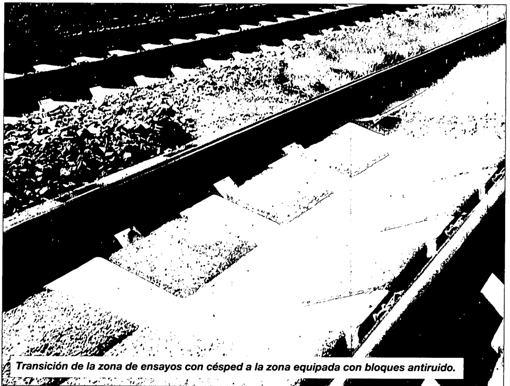
Tramo de ensayo en Waghäusel con relleno lateral de balasto como antiruido.
