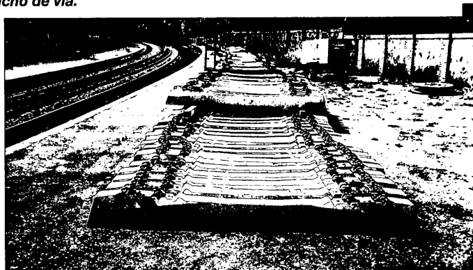
Fig. 3.- Traviesas bivalentes preparadas para situar en vía de 1668 mm, en las que se ven los dos juegos de ranuras, uno para cada ancho de vía.
