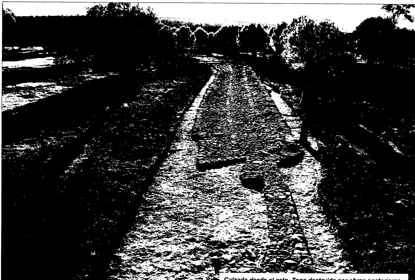
Calzada desde el este. Zona destruida por obras posteriores y amortización de materiales de construcción.
