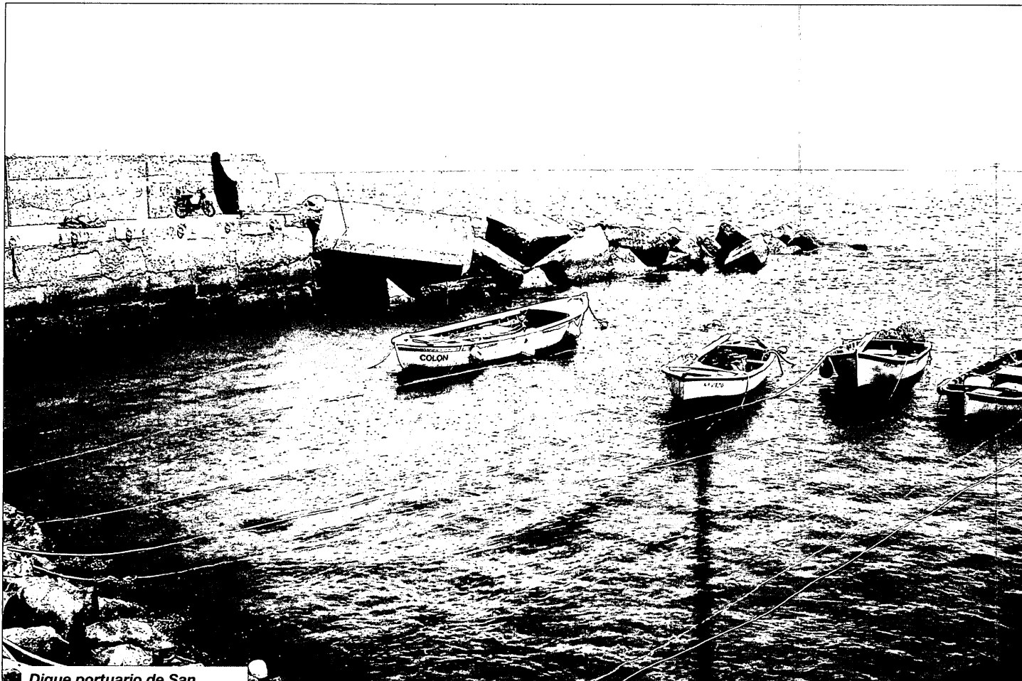
Dique portuario de San Cristóbal (Gran Canaria): Construido en 1989-90 y destruido en gran parte en 1994 por un temporal cuya altura de ola significativa en aguas profundas era H_{so} = 4,6 m. El dique había sido proyectado para soportar un oleaje de H_{so} = 7,3 m sin daños.
