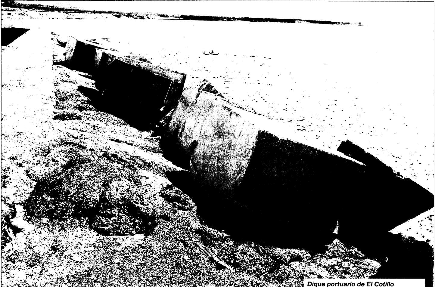
Dique portuario de El Cotillo (Fuerteventura). Construido en 1993. Averiado muy gravemente poco después de su construcción por un temporal ordinario, tuvo que ser reforzado de manera muy importante para evitar su rápida destrucción total, remodelando las secciones del dique en profundidad. A pesar de ello ha sufrido desde entonces problemas recurrentes, y el año pasado otra vez averías serias.
